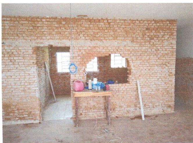
DEMOLIÇÃO REBOCO E ALVENARIA
