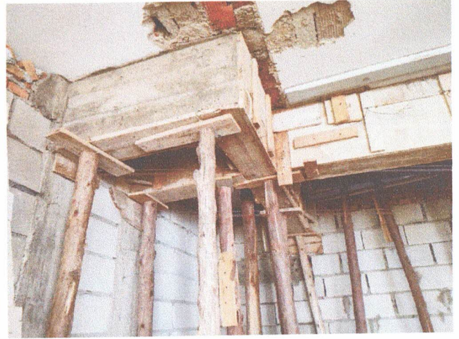
ESTRUTURA JÁ CONCRETADA (FORMA/ARMÇÃO E CONCRETO) / ESCORAMENTO
