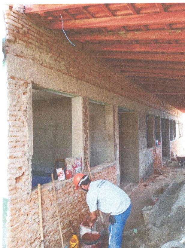
VISTA DO ENGRADAMENTO E TELHAS
