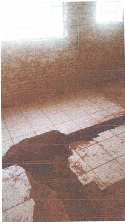
PERFURAÇÃO ESTACA BROCA E BALDRAMES
