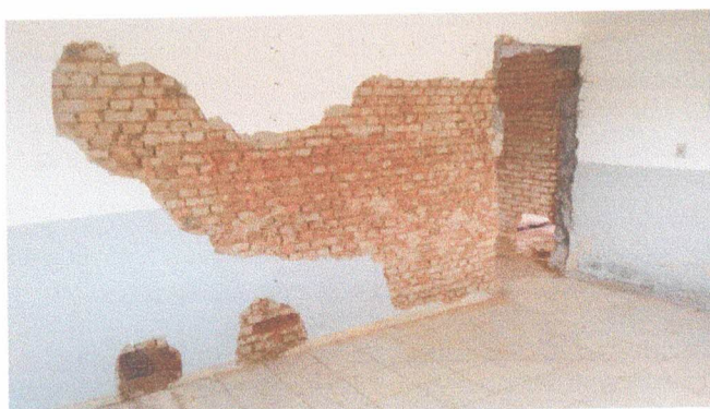
DEMOLIÇÃO REVESTIMENTO (REBOCO)
