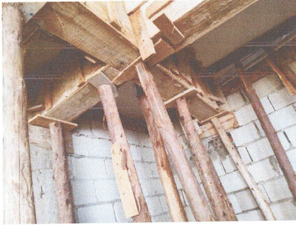
ESTRUTURA JÁ CONCRETADA (FORMA/ARMÇÃO E CONCRETO) / ESCORAMENTO
