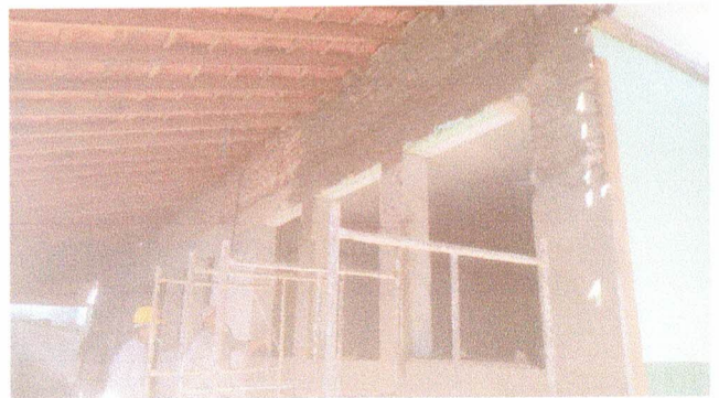
CHAPISCO E REBOCO
