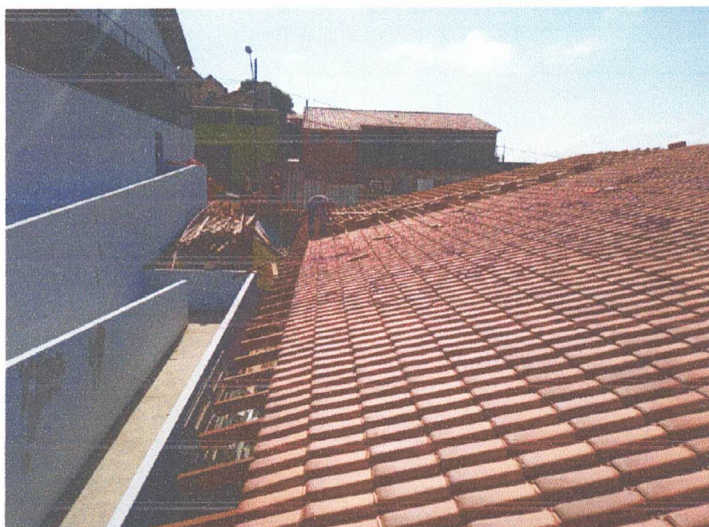
COLOCAÇÃO DE TELHAS CERÂMICAS
