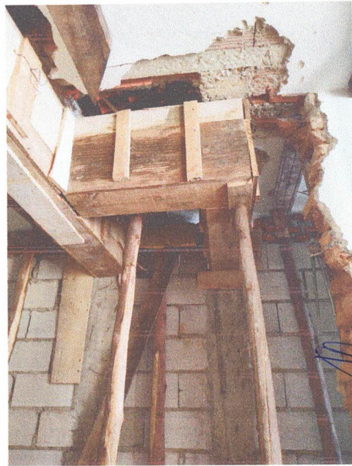
ESTRUTURA JÁ CONCRETADA (FORMA/ARMÇÃO E CONCRETO) / ESCORAMENTO
