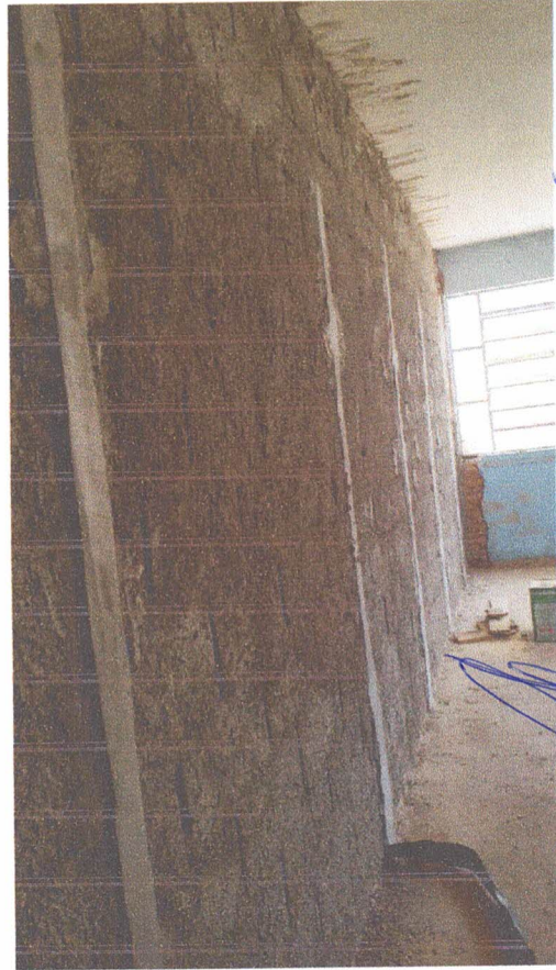
ALVENARIA E CHAPISCO
