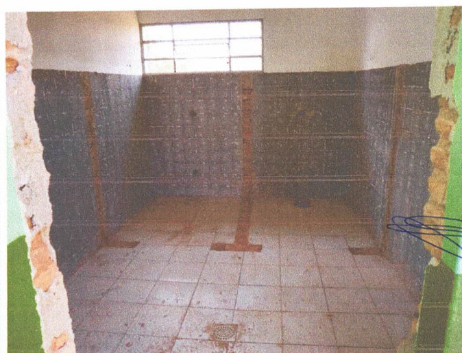
DEMOLIÇÃO ALVENARIA E REVESTIMENTO
