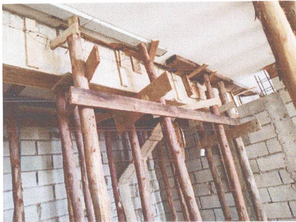
ESTRUTURA JÁ CONCRETADA (FORMA/ARMÇÃO E CONCRETO) / ESCORAMENTO
